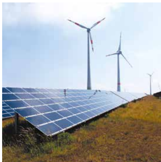
▲ Éoliennes et panneaux solaires à Schneebergerhof (Allemagne).
